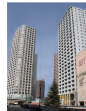
対象集合住宅は 10 棟
